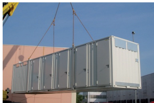
Movimentazione del container
