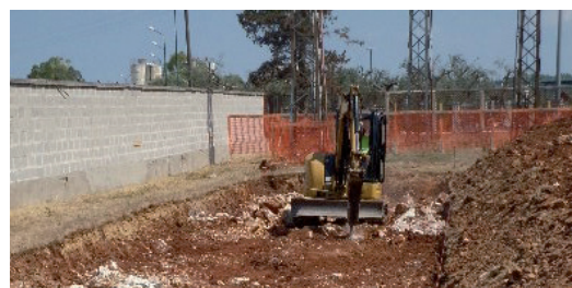
Predisposizione delle aree per la sistemazione del container
